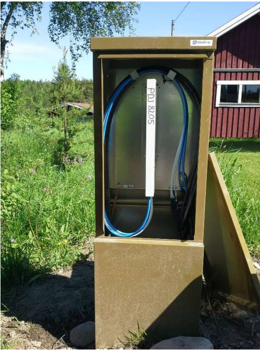
Kuva 7.1.11.2. Flex-kuituputkien suojaamisesta pienessä liityntäverkkojen jatkoskaapissa paineilmaletkulla.
