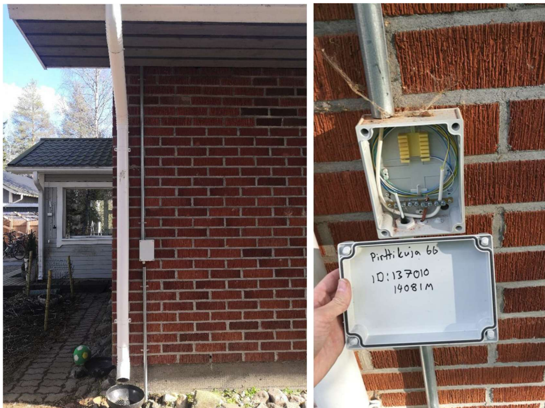
Kuva 7.8.2 Valmis asennus kiinteistön ulkoseinällä
